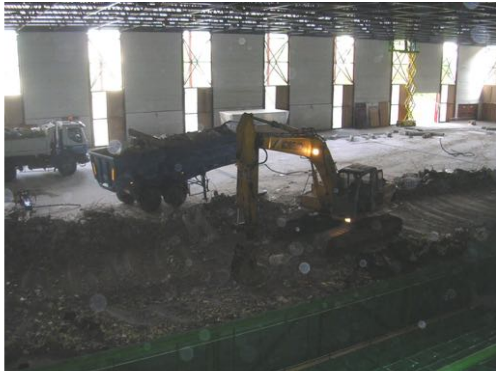
Réfection de la dalle
