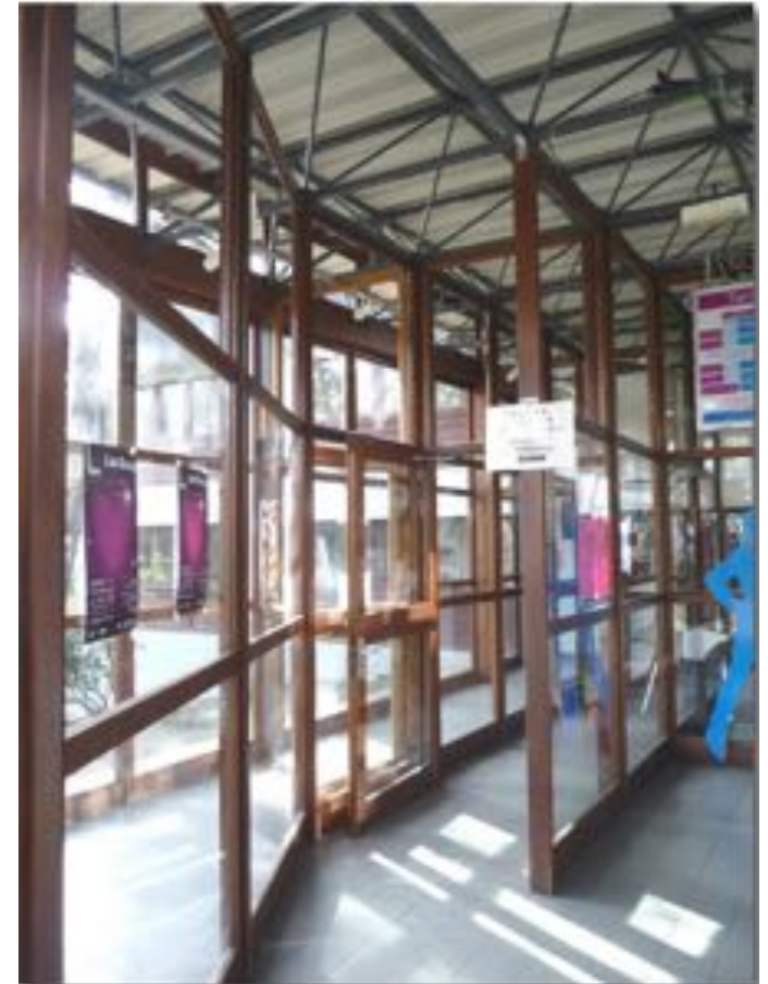
Hall d'entrée avant travaux
