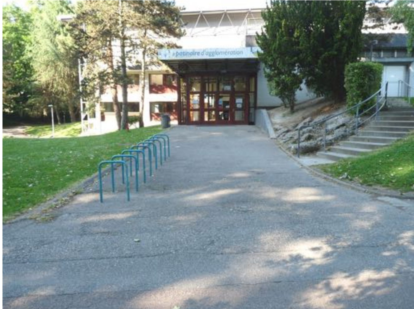
Entrée avant travaux
